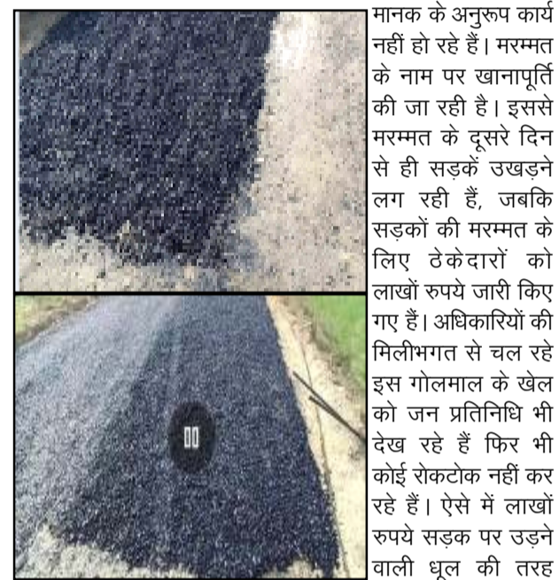
मानक के अनुरूप कार्य नहीं हो रहे हैं। मरम्मत के नाम पर खानापूर्ति की जा रही है। इससे मरम्मत के दूसरे दिन से ही सड़कें उखड़ने लग रही हैं, जबकि सड़कों की मरम्मत के लिए ठेकेदारों को लाखों रुपये जारी किए गए हैं। अधिकारियों की मिलीभगत से चल रहे इस गोलमाल के खेल को जन प्रतिनिधि भी देख रहे हैं फिर भी कोई रोकटोक नहीं कर रहे हैं। ऐसे में लाखों रुपये सड़क पर उड़ने वाली धूल की तरह उड़कर ठेकेदारों और अधिकारियों की जेब में चले जा रहे हैं।
